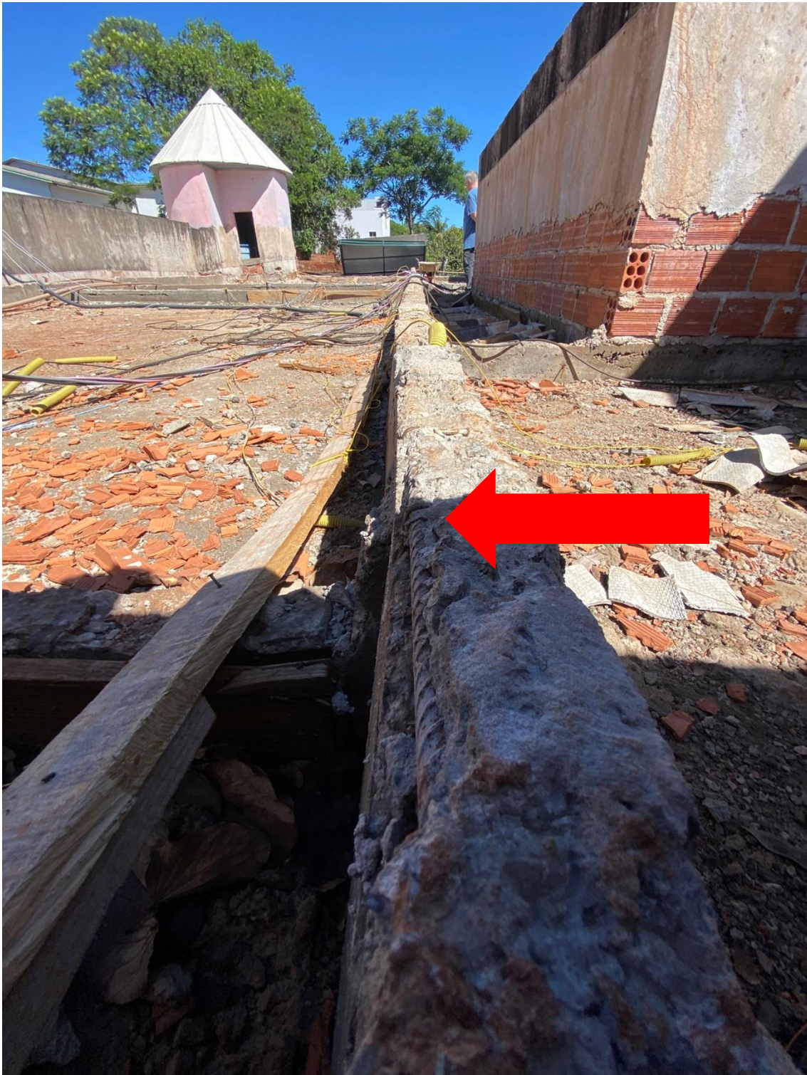
Figura 50 - Vista longitudinal da viga da figura 49.
