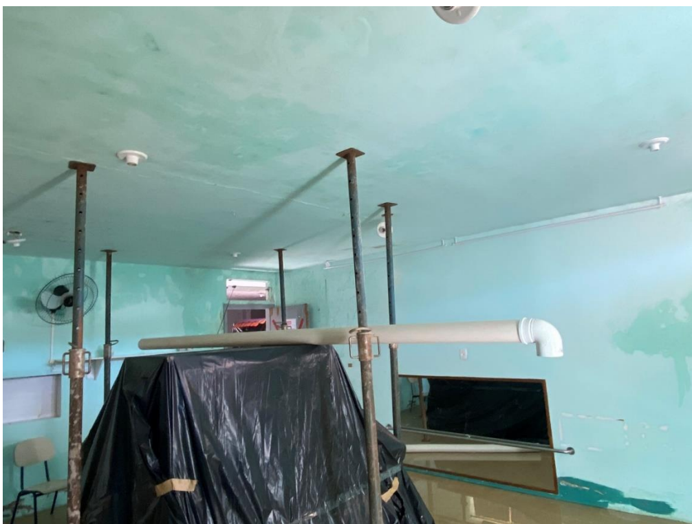
Figura 8 - Vista da sala frontal. Destaque para as escoras metálicas.
