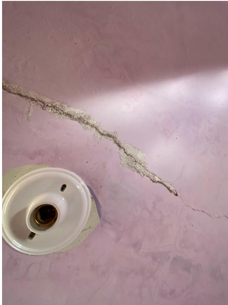
Figura 32 - Detalhe aproximado da trinca da laje.
