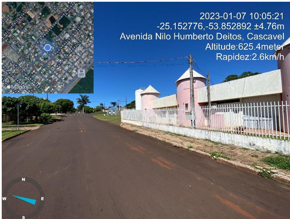
Figura 5 - Vista da rua de acesso da edificação.
