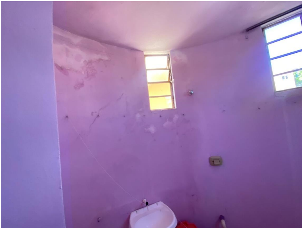
Figura 27 – Vista do banheiro anexo a sala dos fundos.
