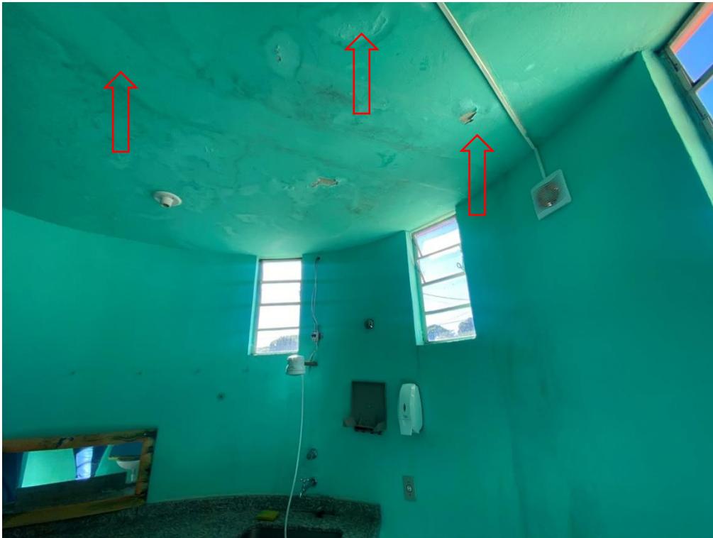
Figura 21 – Vista do banheiro com detalhe da umidade e do recorte da estrutura.
