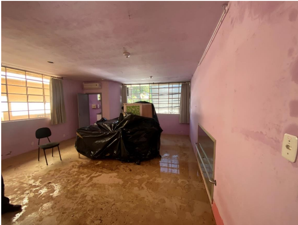
Figura 22 – Vista da sala dos fundos.
