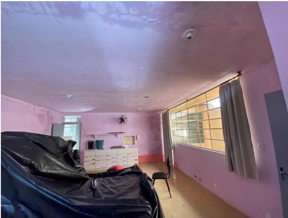
Figura 26 – Vista da sala dos fundos.
