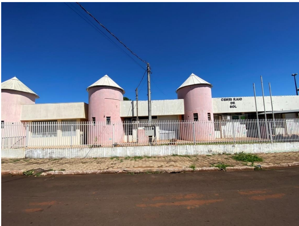
Figura 4 - Fachada Principal do Imóvel.
