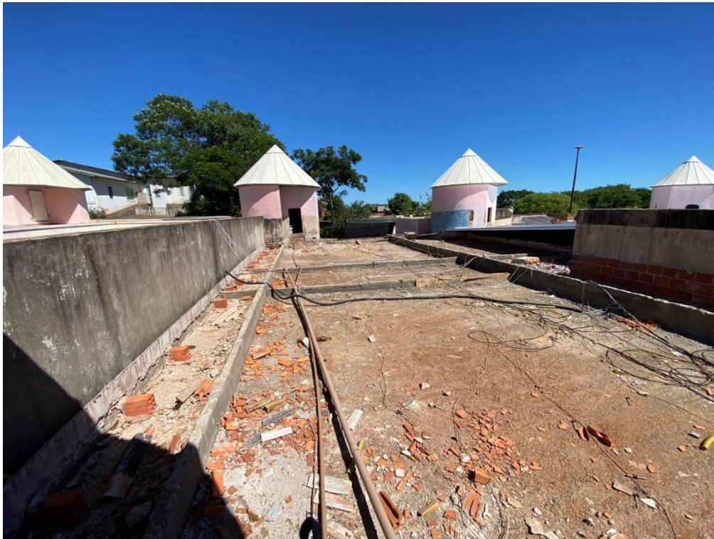
Figura 54 - Vista da laje de cobertura.
