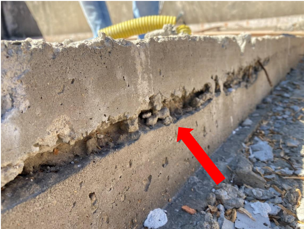
Figura 38 – Vista de nicho de concretagem.
