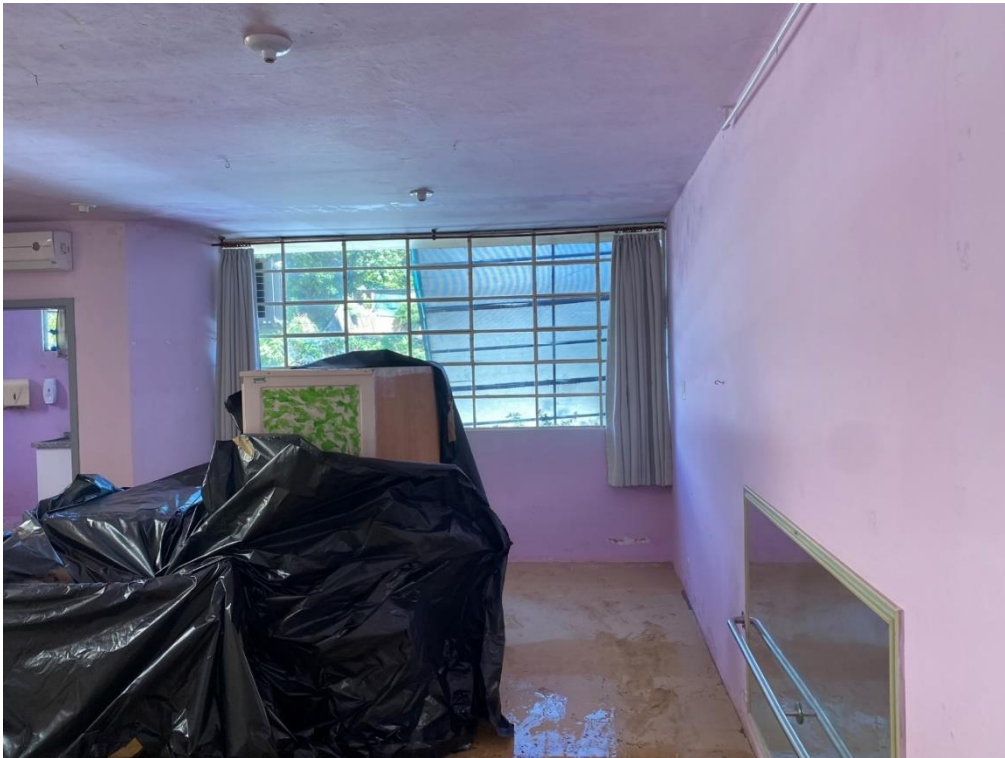
Figura 24 – Vista da sala dos fundos.
