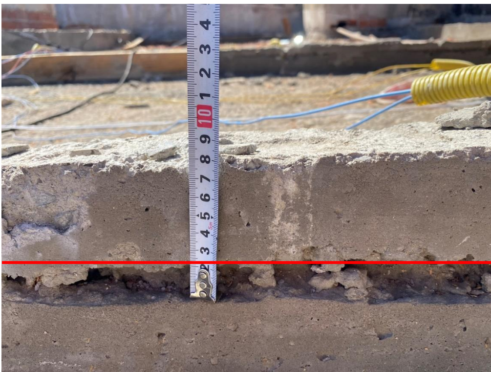
Figura 39 - Vista da dimensão do nicho em viga. Aproximadamente 2,3 centímetros (cm).
