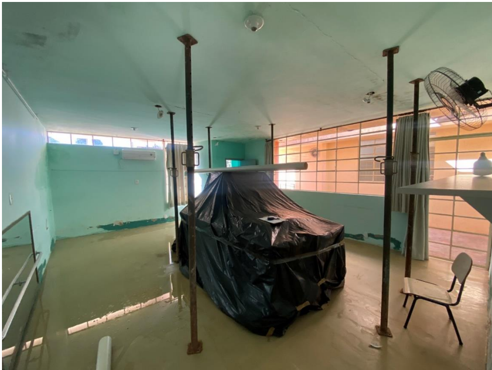
Figura 7 – Vista da sala frontal. Destaque para as escoras metálicas.
