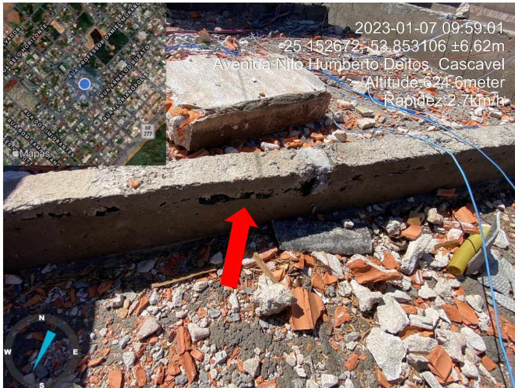
Figura 47 - Viga com nicho de concretagem.
