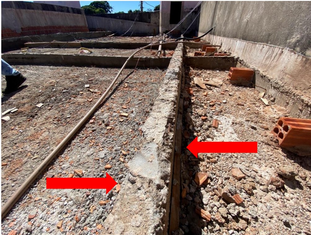
Figura 36 – Vista do desaparecimento de viga.
